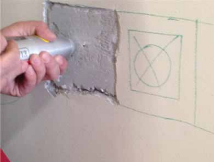
Şekil 7 - Karot nümunesi alınacak yerin yanı başında Beton Çekici okumaları (tahribatsız yöntem)
