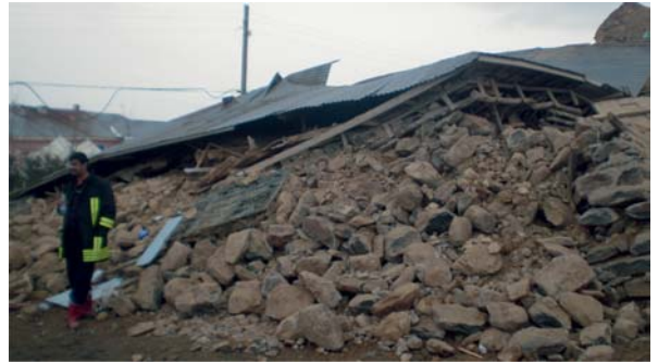
Şekil 8 - Okçular köyündeki çamur harçlı moloz taş duvarlı yapı enkazı
