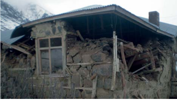
Şekil 11 - Yukarı demirci köyünde ağır toprak damlı harçsız sayılabilecek yıkık yapı örnekleri
