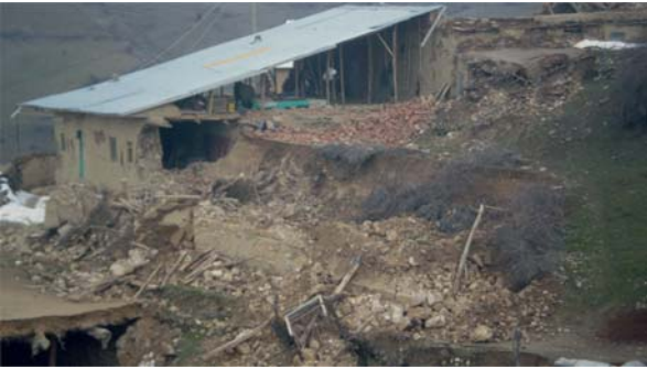
Şekil 7 - Okçular köyündeki yapı enkazları
